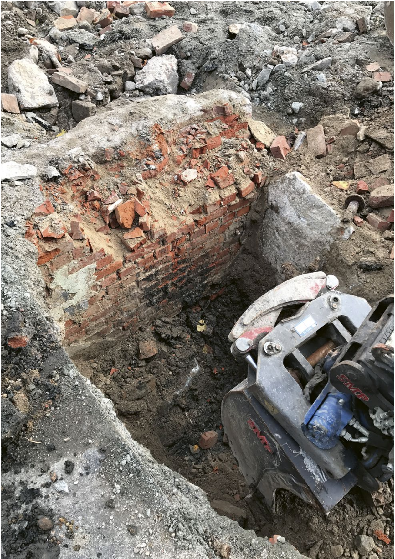
Figur 15. Översikt över västra delen av schakt 11. I botten fanns vallgravssediment (som knappt syns på bilden). Foto: Veronica Forsblom-Ljungdahl.
